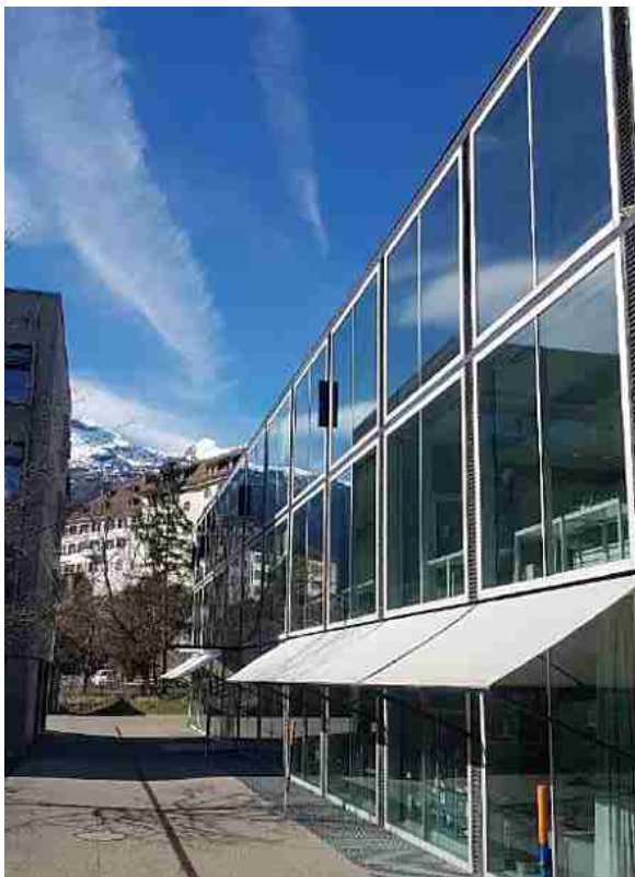
Abb. 31: Solche spiegelnden Fensterfronten wie hier an einem Gebäude der Kantonsschule können für Vögel zur tödlichen Falle werden. © Patrick Marti
