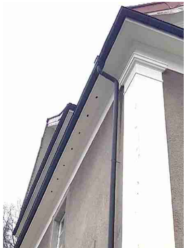
Abb. 32: Während Renovationsarbeiten konnten hier (Planaterra 11) mit wenig Aufwand Hohlräume im Vordach für Mauersegler zugänglich gemacht werden. © Patrick Marti
